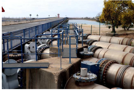
Puente Sifón de Santa Eulalia en el río Odriel
