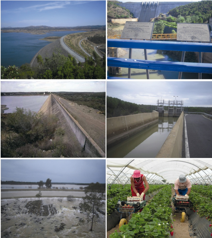
Figura 13. Infraestructuras hidráulicas del Sistema Andévalo-Chanza-Piedras-Machos y campos de fresas en Huelva
