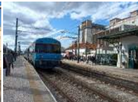
Estación de Faro
