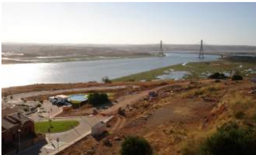
FIGURA 15 | Puente Internacional del Guadiana. Transporte por carretera
