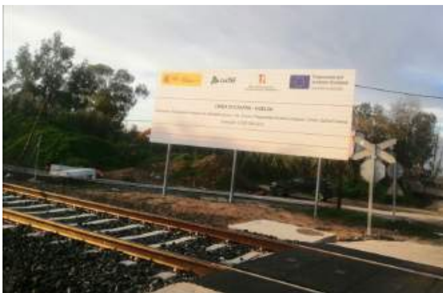
FIGURA 7 | Obras de rehabilitación. Tramo Huelva-Peguerillas (2024)
